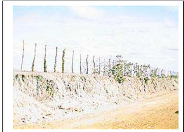
FOTO 2.10 - Corte de estrada que liga as localidades de Estreito a Vieira, em área de afloramento eluvionar de argilas.
