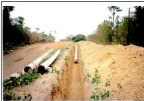
FOTO 4.1 – Implantação da tubulação do GASFOR.
