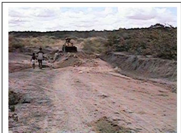
FOTO 2.12 - Estrada de acesso ao Cabeço Branco. Detalhe para as escavações laterais em vertissolos argilosos.
